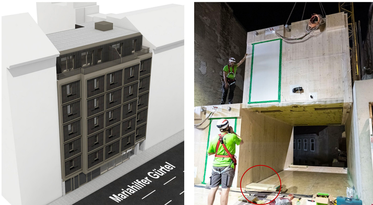
Abbildung 4.2 Darstellungen des Projektes The Wood – Boutique Hotel Wien; Visualisierung von der Straße (links), Foto der Positionierung eines Raummoduls (rechts) ©SIHGA [8]
